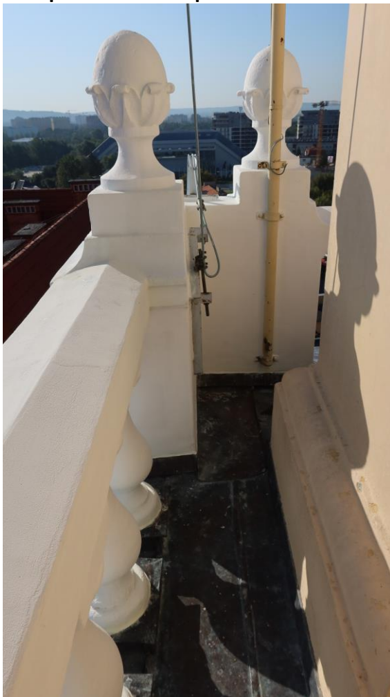
Stan po zakończeniu prac:
