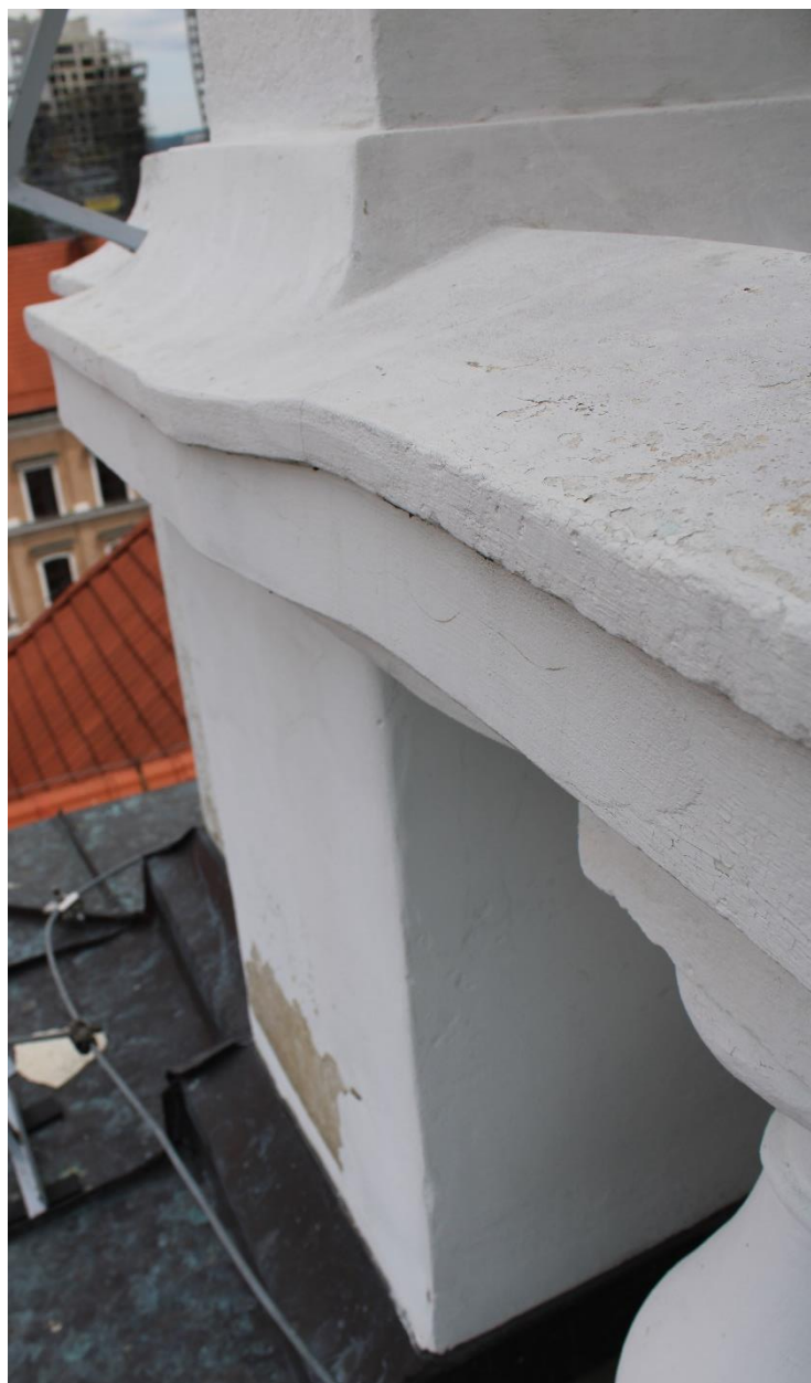
Fot. 19 Narożnik 4 -widok od strony zewnętrznej 2
