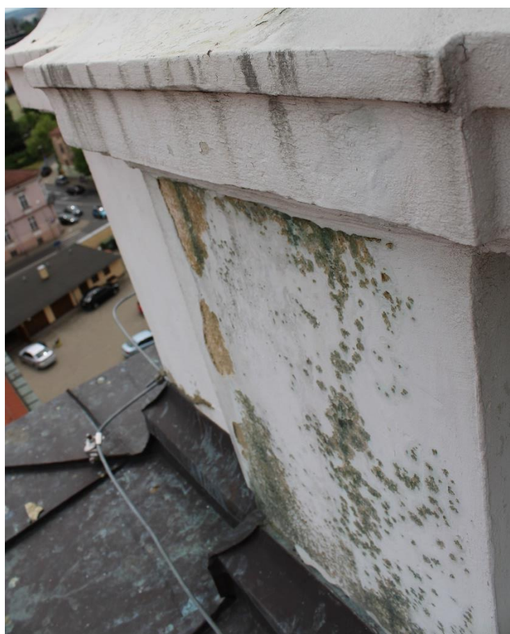
Fot. 12 Narożnik 2 – widok od strony zewnętrznej
