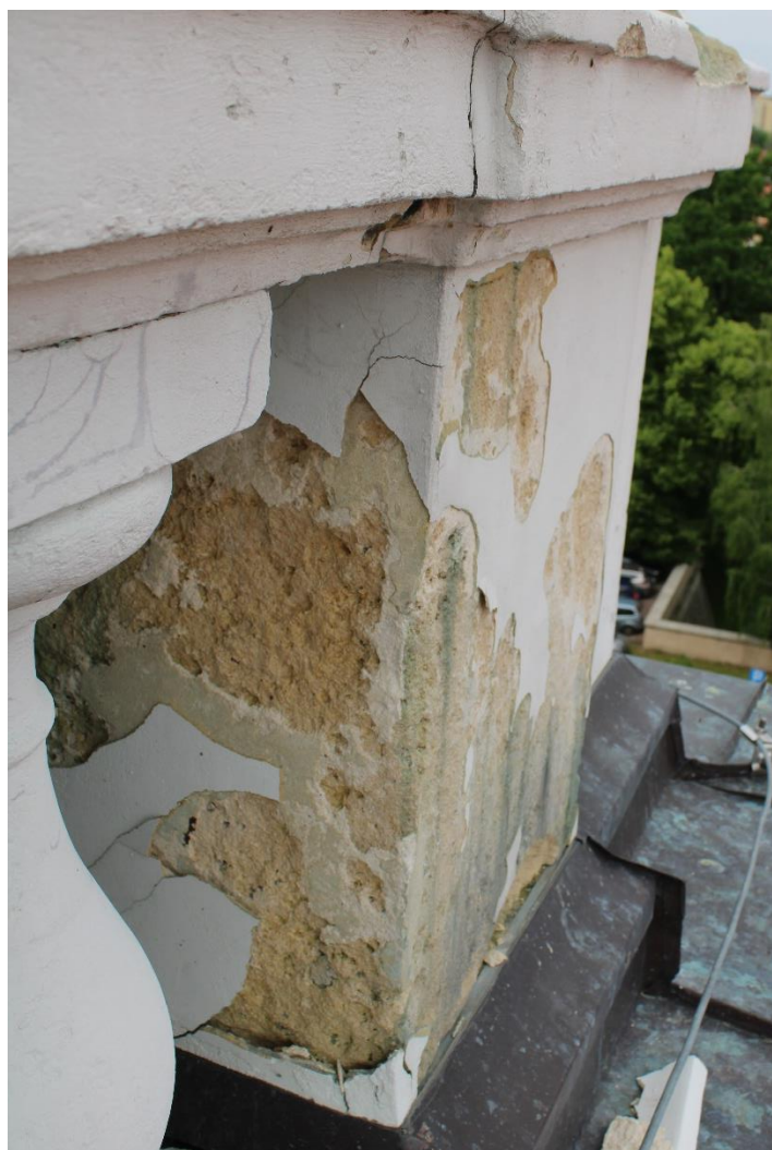
Fot. 10 Narożnik 1 -widok od strony zewnętrznej
