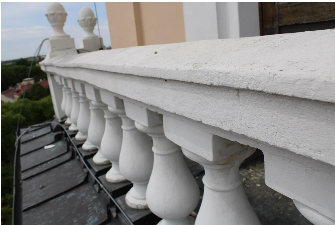
Fot. 24 Widok tralek od strony zewnętrznej
