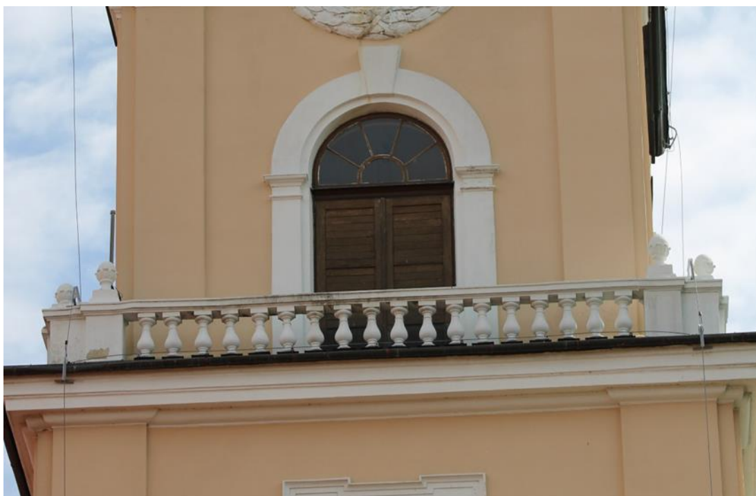
Fot. 7 Balustrada strona boczna - północna
