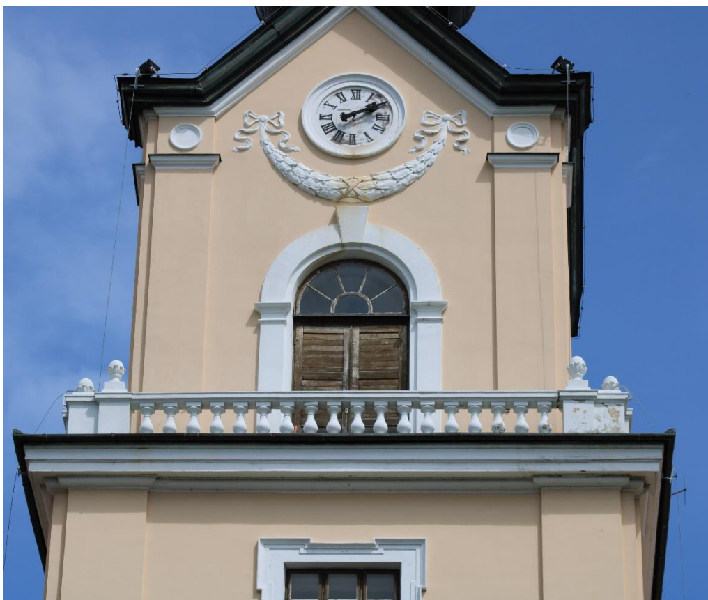
Fot. 4 Ściany zewnętrzne wieży zegarowej w kondygnacji VI
