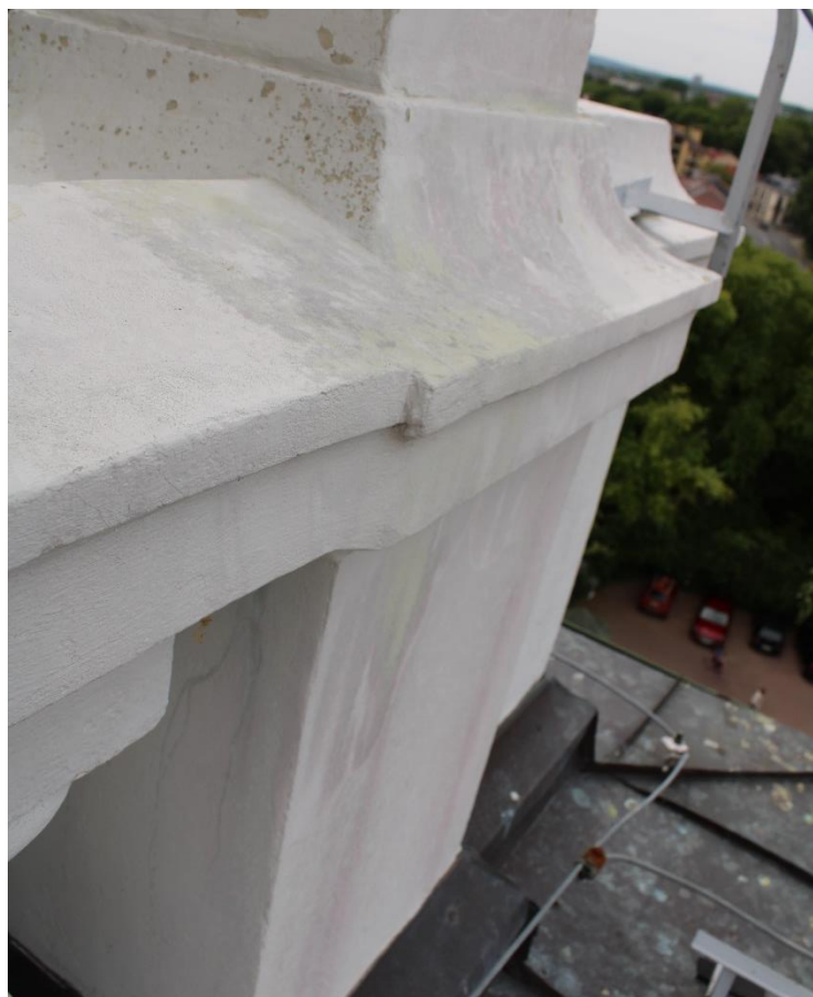
Fot. 17 Narożnik 4 – widok od strony zewnętrznej
