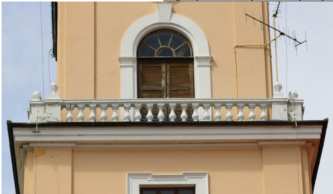
Fot. 8 Balustrada strona boczna - południowa
