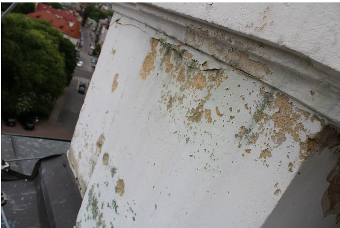
Fot. 15 Narożnik 3 – widok od strony zewnętrznej
