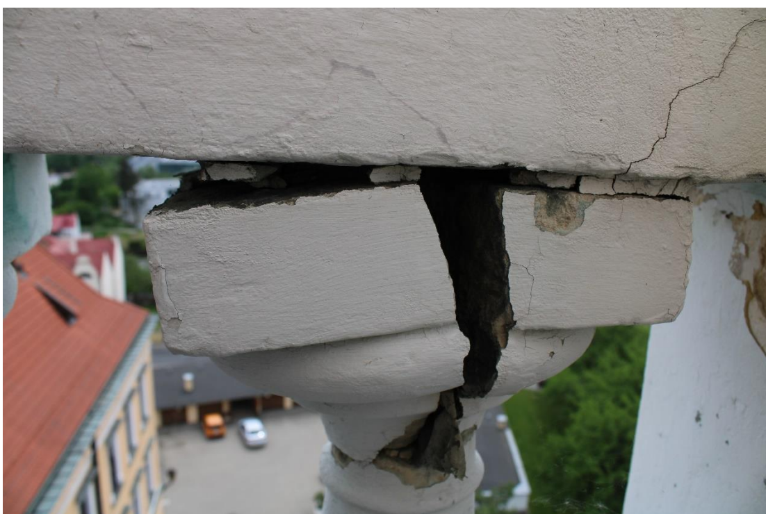
Fot. 21 Rozłupanie graniastosłupa górnego tralki
