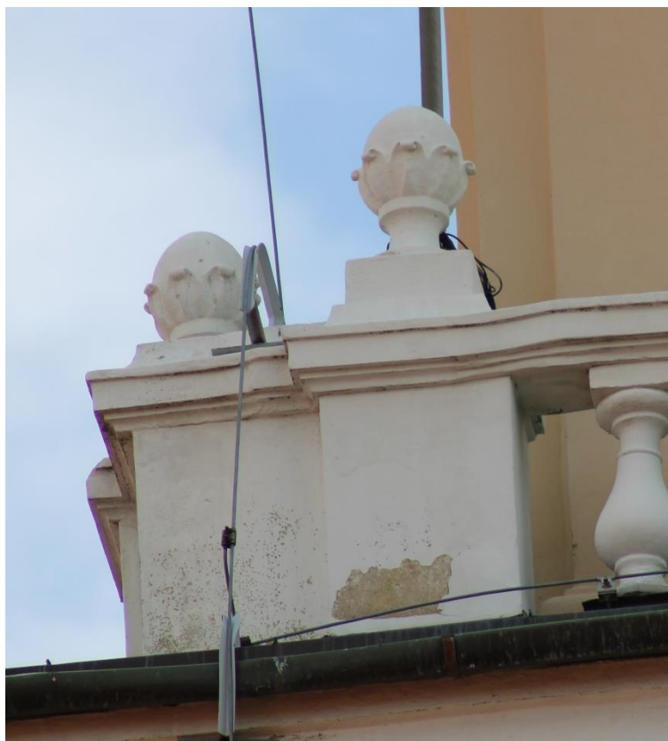
Fot. 1 Narożne cokoły balustrady w kondygnacji VI
