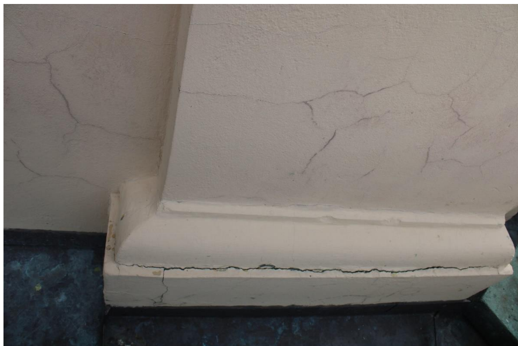
Fot. 5 Cokół ściany (gzyms) w miejscu ryzalitu
