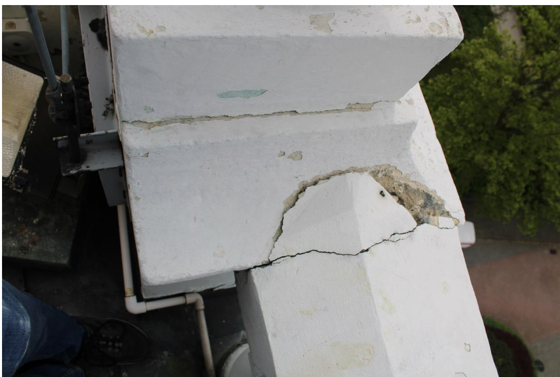
Fot. 16 Narożnik 3- szczegół połączenia z balustradą
